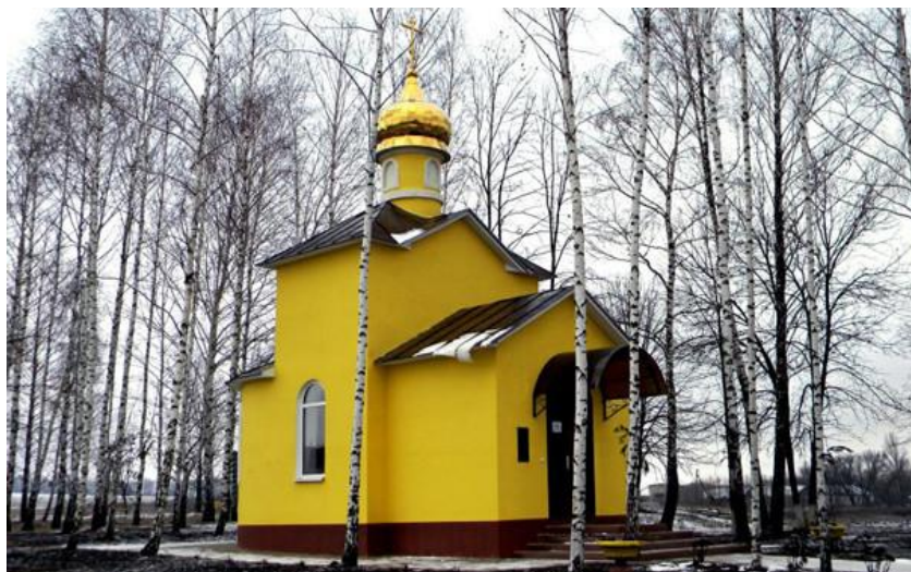
Часовня Иоасафа Белгородского, с. Афанасово, 2012 г.
